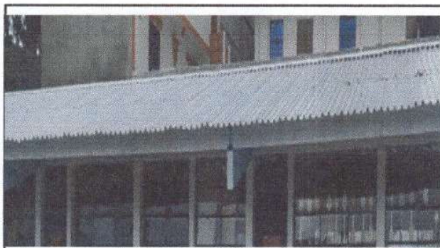
Foto 4: CAMBIO DE LAMINA TROQUELADA EN AULAS
