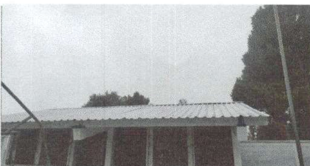
Foto 5: CAMBIO DE LAMINA TROQUELADA EN BAÑOS
